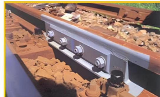
La **VERIFICA** delle giunzioni incollate isolanti è fondamentale per garantirne l'integrità strutturale, l'isolamento elettrico e la durata nel tempo.
